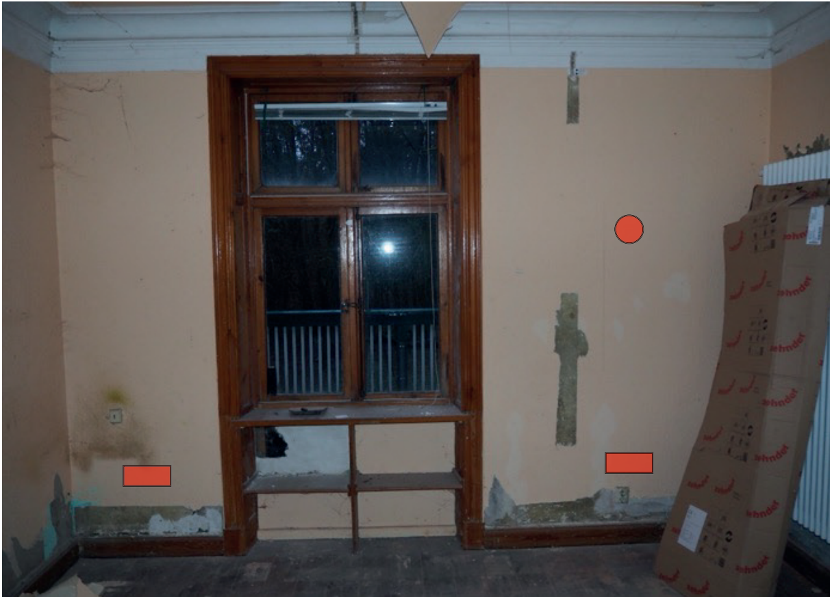
Abbildung: Seminarraum 3 – Fenster Richtung Veranda
