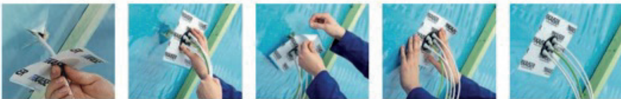
Abbildung: Verwendung von Dichtungsmanschetten
