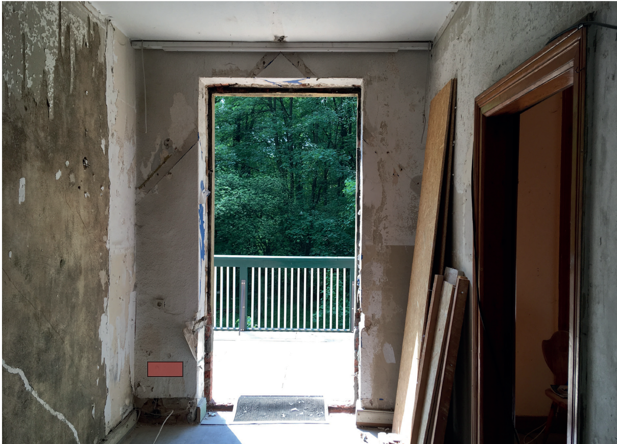
Abbildung: Balkontür 1. OG zur Veranda
