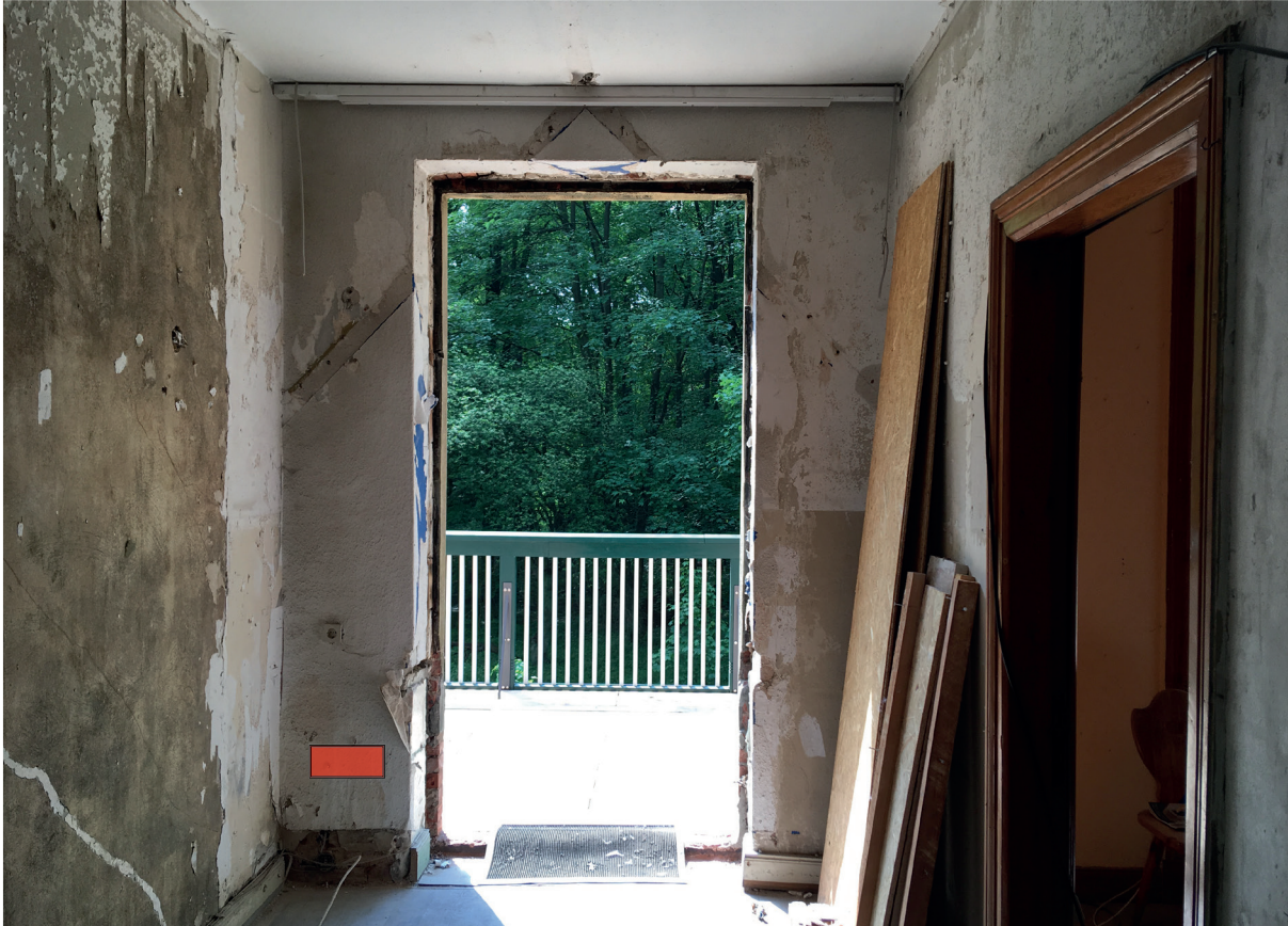
Abbildung: Balkontür 1. OG zur Veranda
