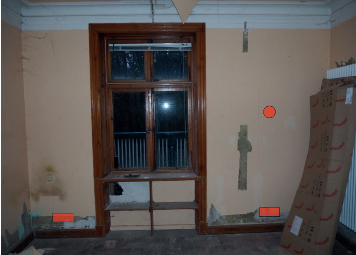
Abbildung: Seminarraum 3 – Fenster Richtung Veranda
