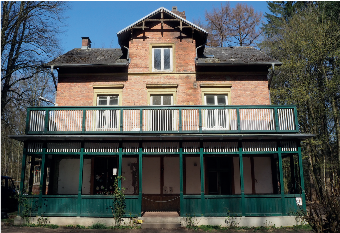
Ort der Elektroinstallation: Die Villa Mutzenbecher
